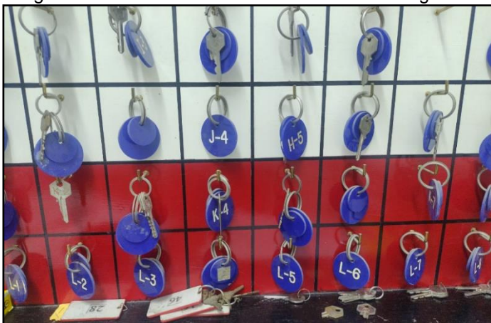
Imagen No 2 Tablero de llaves en Comando de vigilancia
