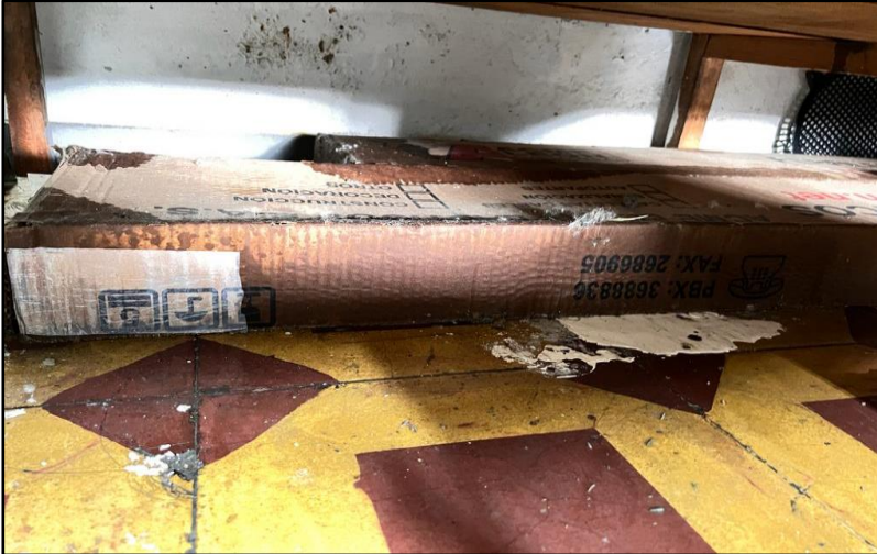
Imagen No. 01 Bodega Almacén COBOG
